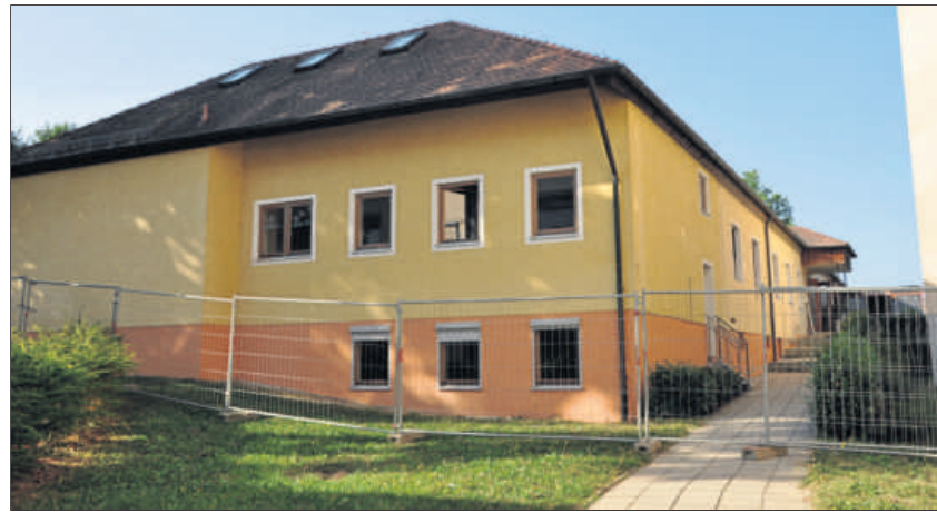
Ein Bauzaun umgibt das alte Kindergartengebäude. Im Inneren wird bereits kräftig entkernt und für die Generalsanierung gearbeitet. Bilder: swt (2)
